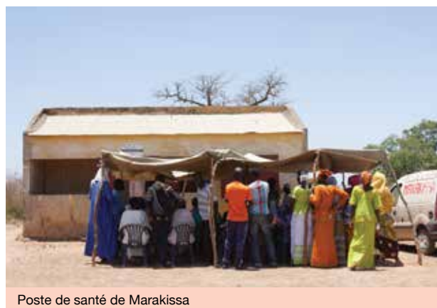
Poste de santé de Marakissa
