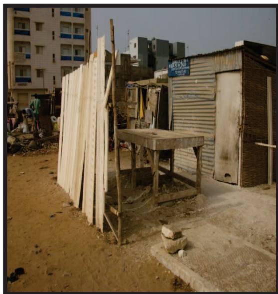
Photo 2 : Atelier de faux plafonds à Dakar
