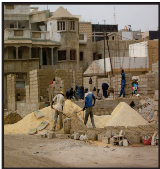
Photo 1 : Maçons dans un chantier à Dakar
